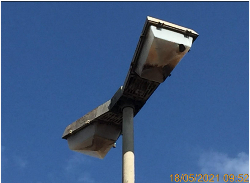
Detalhe da luminária existente com difusores danificados
