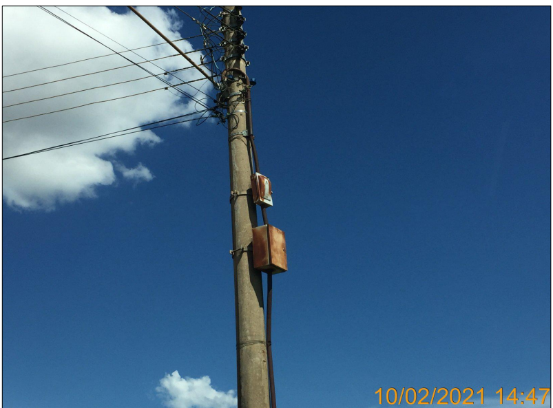
Entrada de energia existente sem medidor
